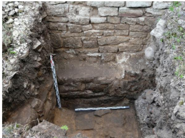
Рис. 5. Порховская крепость. 2014 г. Шурф № 15. Расчистка фундамента стены. Вид с востока
