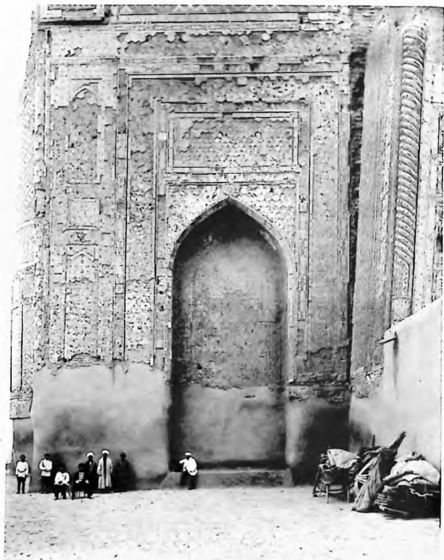
Самаркандская обл. Шахрисябз. Дворец Ак-Сарай. Низ левой щеки главного фасада. Фото Н.П. Петровского, 1895 г.
