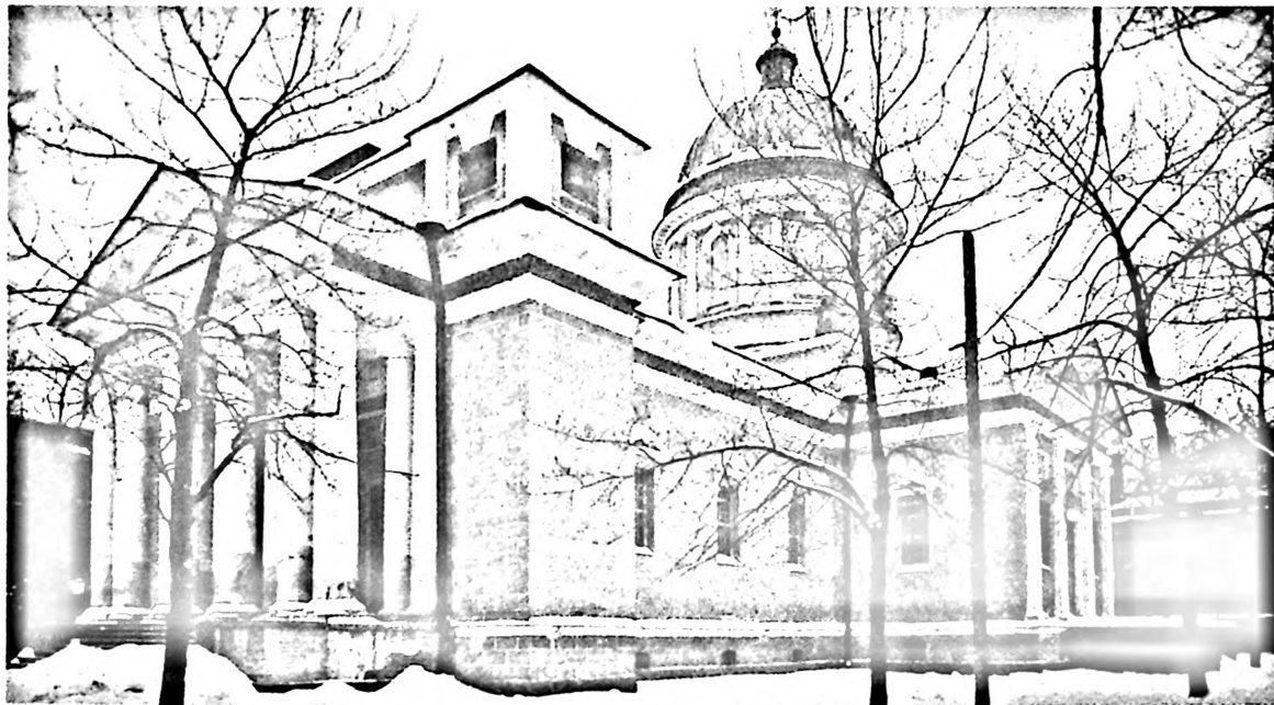
Церковь апостола Павла в селе Александровском.
