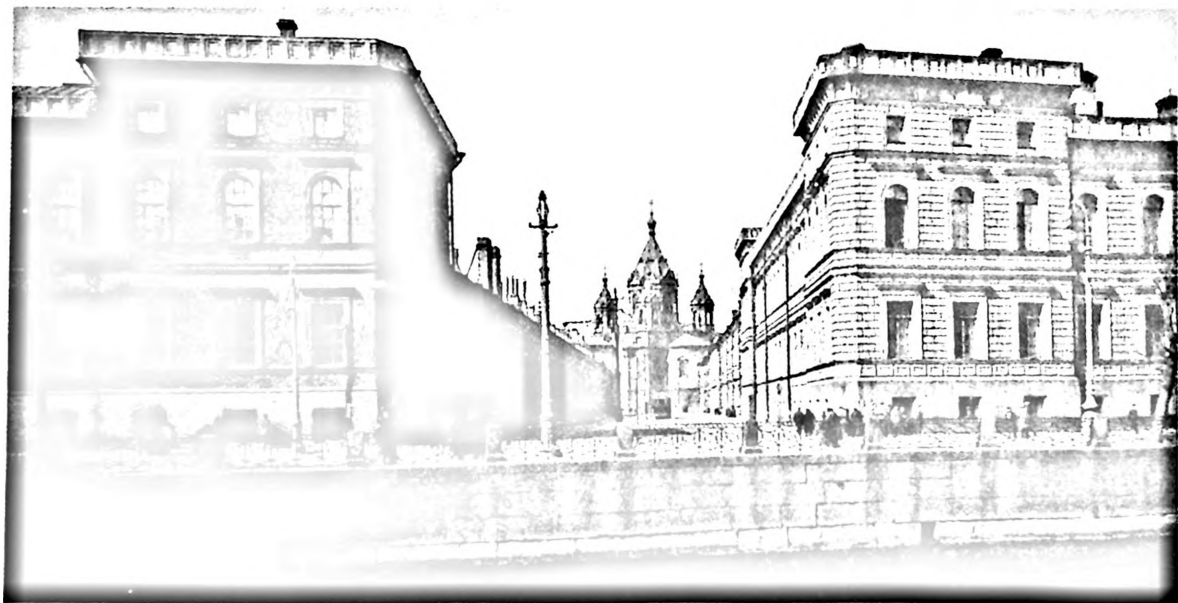
Благовещенская церковь Конного полка. Вид со стороны набережной Мойки.
