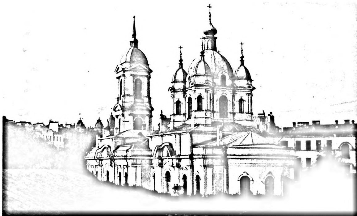
Матфеевская церковь. Фото В. Г. Самойлова, 1914 г.
