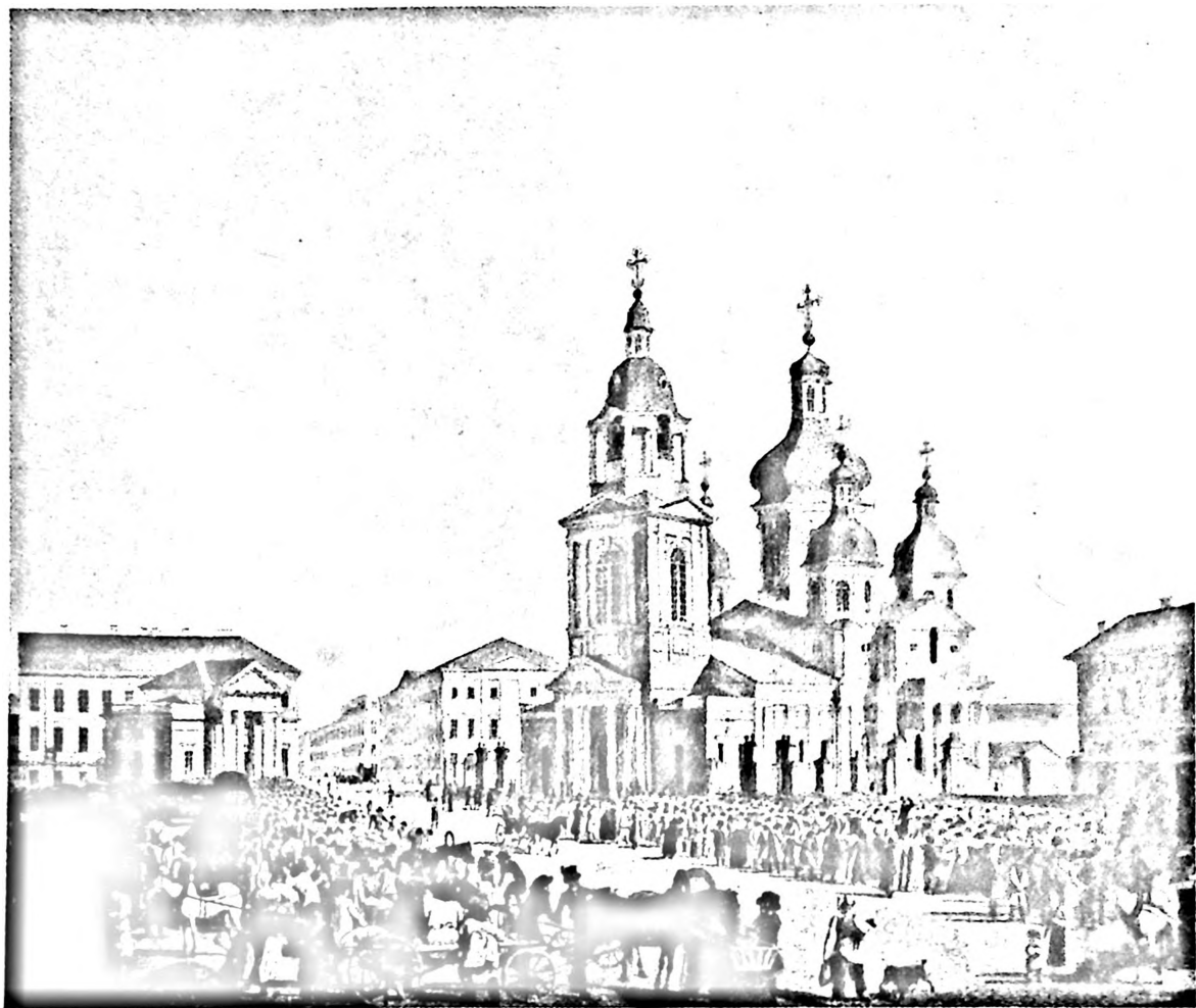
Церковь Успения на Сенной площади.
