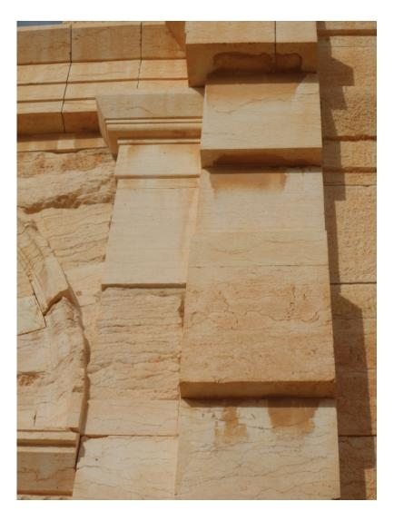
Puc. 21. Биопленки под уступами пилястр (участок, отреставрированный Р. Ами) Fig. 21. Biofilms under pilaster ledges (area restored by R. Ami)
