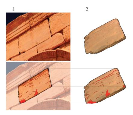
Рис. 13. Поиск блоков, признак 3. Дефекты камня: 1-фото положения блока в объекте; 2- цифровая модель блока
