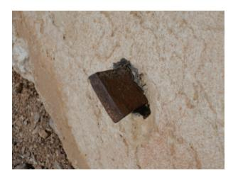
Puc. 12. Металлический «шип», зафиксированный свинцом Fig. 12. Metal "thorn" fixed with lead
