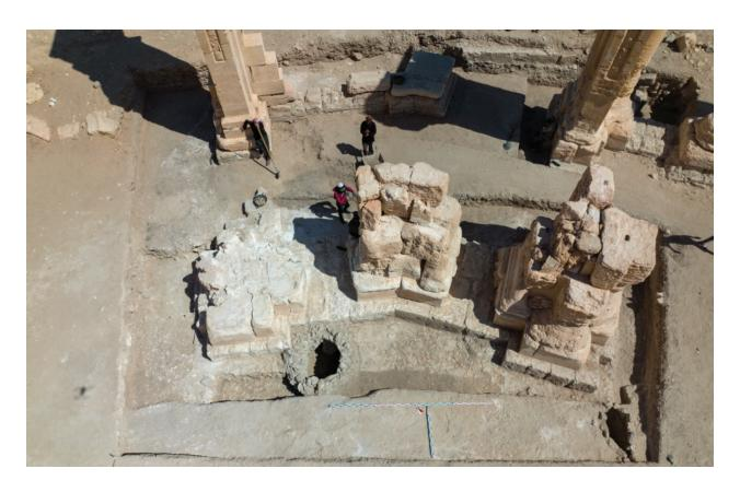
Puc. 12. Триумфальная Арка Пальмиры. Единая платформа фундамента под пилонами A, A/F и F Fig. 12. Triumphal Arch of Palmyra. Single foundation platform under pylons A, A/F and F
