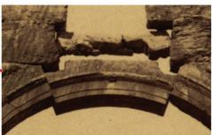
Puc. 7. Введенная Р. Ами узкая вставка в центральной части Арки не подлежит восстановлению Fig. 7. The narrow insertion introduced by R. Ami in the central part of the Arch cannot be restored
