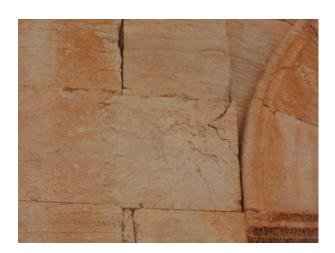
Puc. 18. Следы попадания снаряда (в центре) Fig. 18. Traces of a shell hit (in the center)
