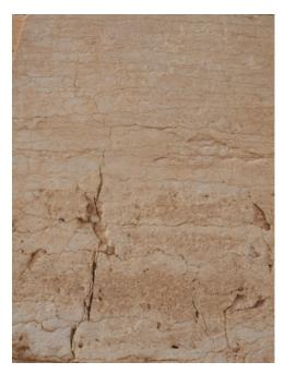
Puc. 16. Развитие вертикальных трещин, соединяющих горизонтальные стилолитовые швы Fig. 16. Vertical cracks extension connecting horizontal stylolite seams
