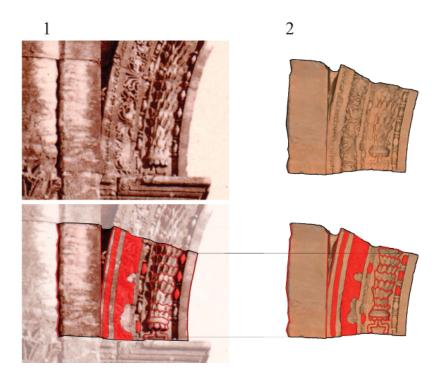
Рис. 12. Поиск блоков, признак 2. Орнамент на фасаде камня: 1 – фото положения блока в объекте; 2 – цифровая модель блока
