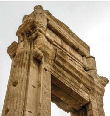
Рис. 15. Вертикальная плита заполнения в пространстве между карнизом портала храма Бэла и вышележащим архитравом. Фото с натуры
