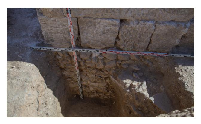
Рис. 11. Триумфальная Арка Пальмиры. Бутовое основание и каменные блоки фундамента Fig. 11. Triumphal Arch of Palmyra. Rubble base and stone foundation blocks
