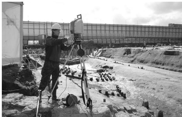
Рис. 5. Процесс лазерного сканирования рва и стен Ниенишанца
