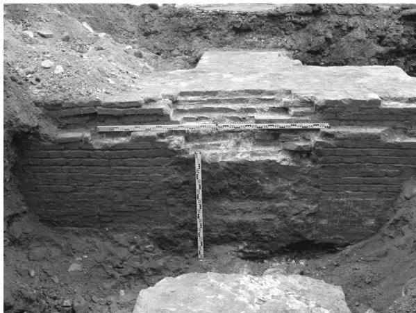
Рис. 11. Старый Гостиный двор. 2009 г. Пересечение поперечной стены и продольной стены 3 со следами сильных разрушений от коммуникаций XX в. Вид с востока
