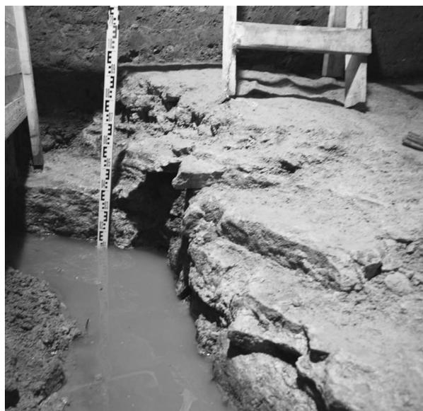
Рис. 2. Шурф 2. Основание фундамента колокольни Смольного монастыря. Фрагмент кладки в южной части шурфа. Вид с востока
