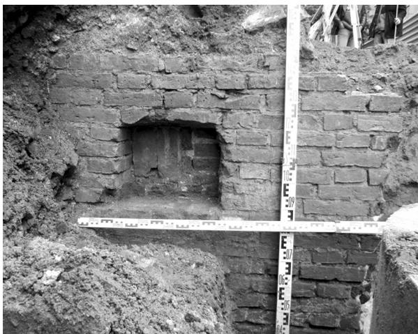
Рис. 14. Старый Гостиный двор. 2009 г. Прямоугольная ниша (гнездо под деревянную балку перекрытия) в западном отрезке продольной стены 3. Вид с юга
