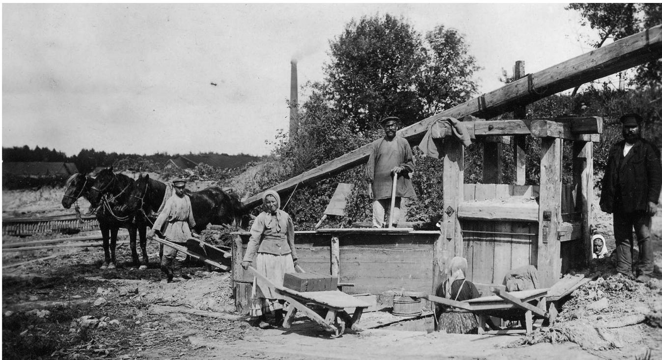
Рис. 4. Глиномятка, земляники и обрезчицы завода Шестова и Липского. Ок. 1900 г. Из архива С. Б. Достовалова
