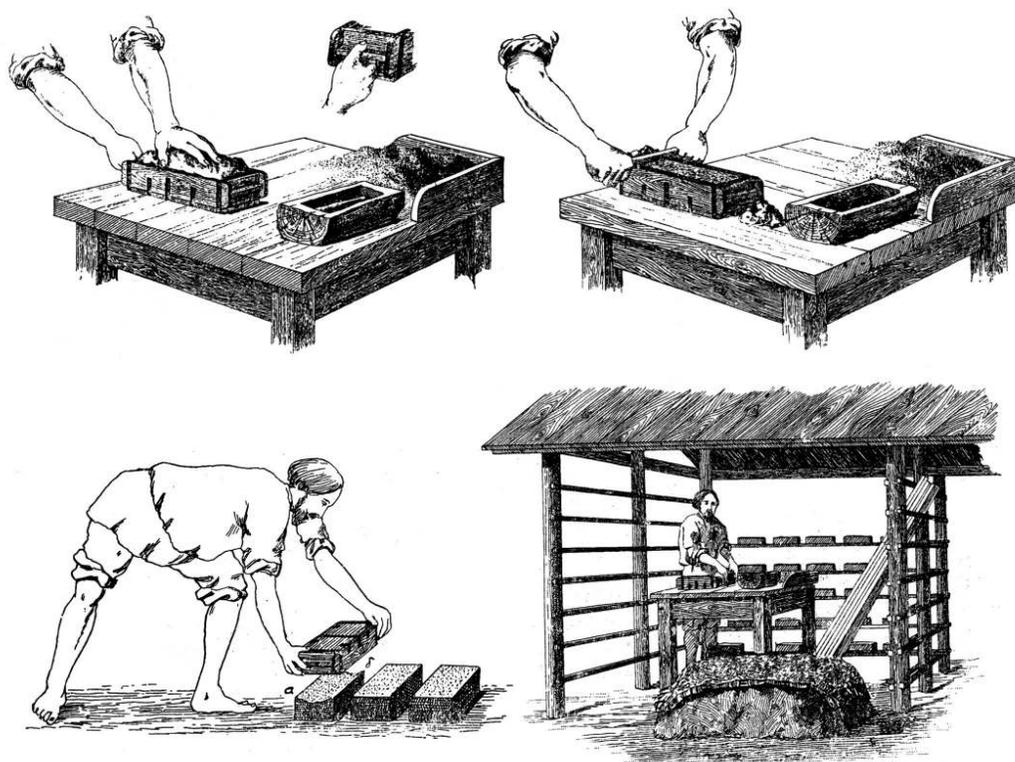
Рис. 5. Рабочее место порядовщика, стеллажи, этапы формовки кирпича. Белавенец, 1905
