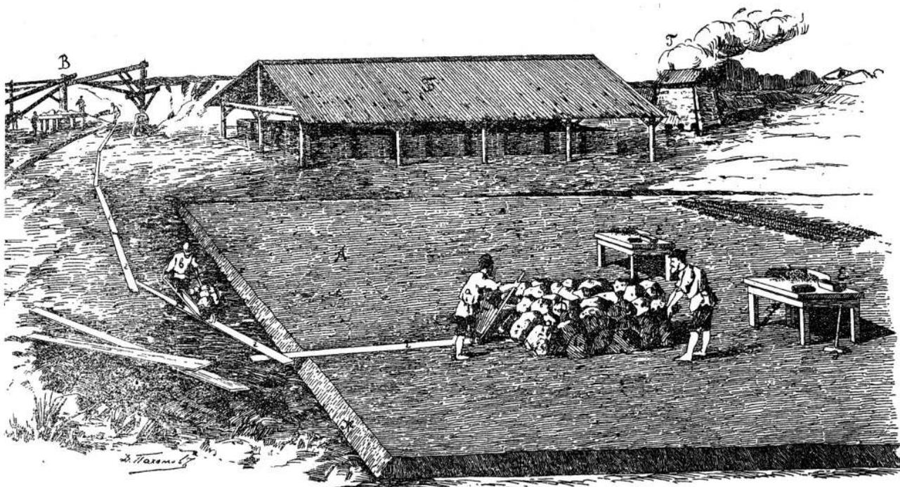
Рис. 3. «Примерный вид кирпичного завода: А) полянка; Б) шатер для складывания и сушки сырца; В) глиномятка; Г) печи для обжига кирпича-сырца; Д) привезенная куча глины; Е) столы, на которых готовится сырец; а, в) рабочий-глинщик; б) порядовщик начинает готовить глину; г) прокатные доски; д) колотушка; е) скребок подложен под ножку стола».
