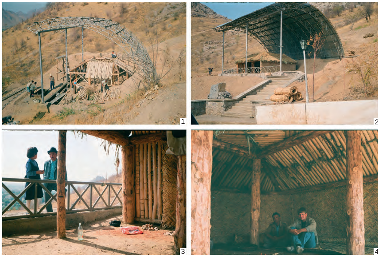
Рис. 3. Ошское поселение, строительство музейной экспозиции. Фото автора
