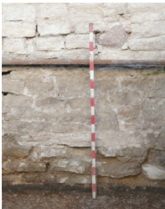
Рис. 9. Основание восточной стены
