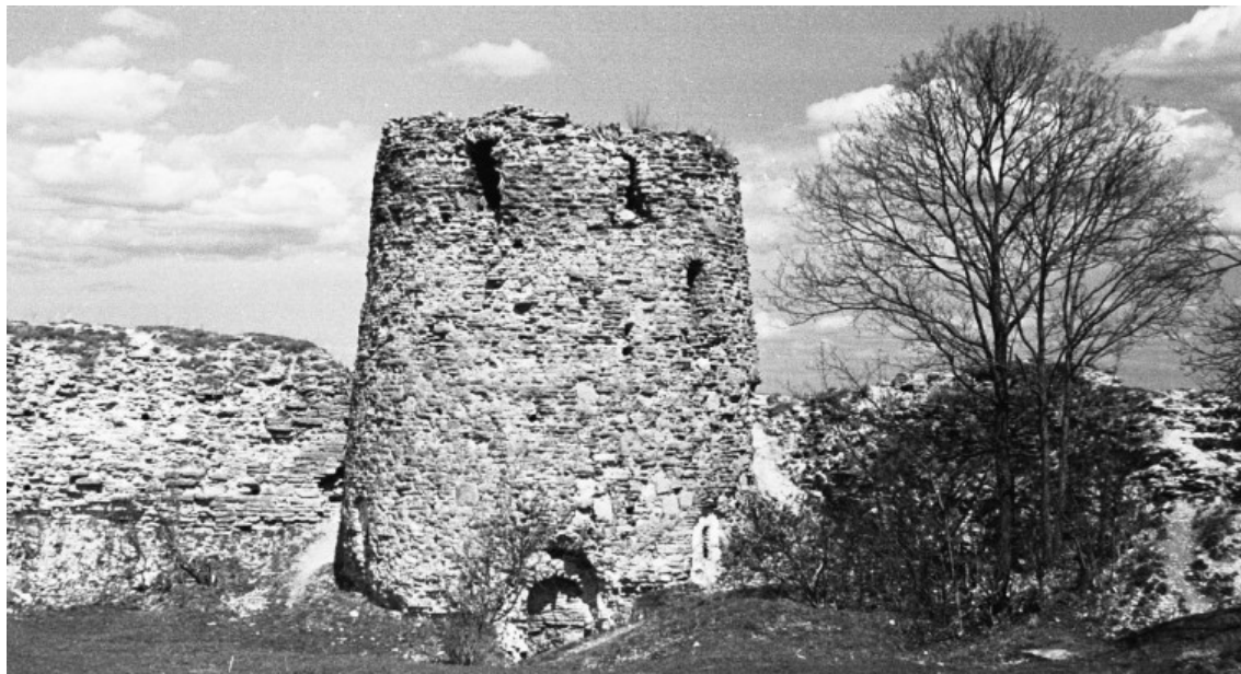
Рис. 2. Башня Луковка до реставрации. Вид с юго-запада. Фото 1960 г. Архив ПСПР
