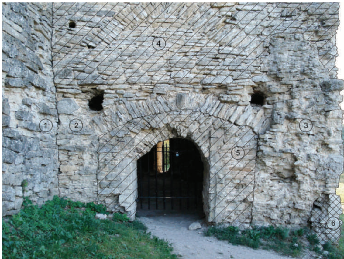
Рис. 11. Талавские захабные ворота, вид с востока. Первый строительный этап: 1 — северная стена крепости; 2 — западная стена захаба с воротами; 3 — фрагмент северной стены захаба. Второй строительный этап: 4 — восточная стена башни Талавской; 5 — закладка ворот захаба и устройство ворот башни; 6 — кладка 1845 г.
